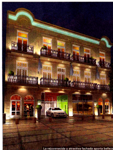
La rejuvenecida y atractiva fachada aporta belleza
