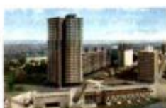
Vista aérea del proyecto
